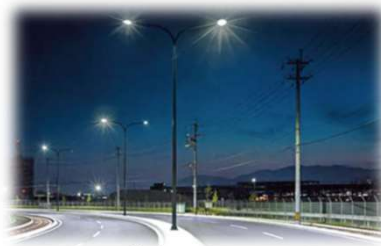
道路照明LED
