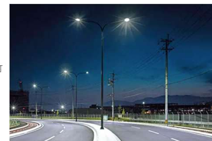
LED化された道路照明
