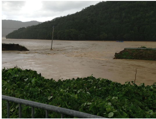
野木川の右岸破堤
