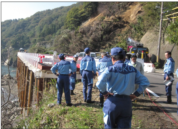
県道常神三方線の仮設橋
