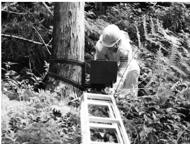
監視カメラの設置
