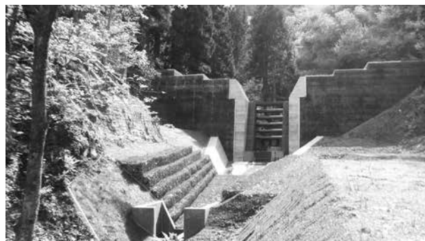
透過型砂防堰堤（滝ヶ谷川 敦賀市田尻）
