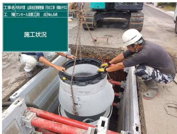
未普及工事【敦賀市】
