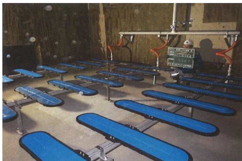
高浜町せーらぎランド老朽化対策工事【高浜町】
