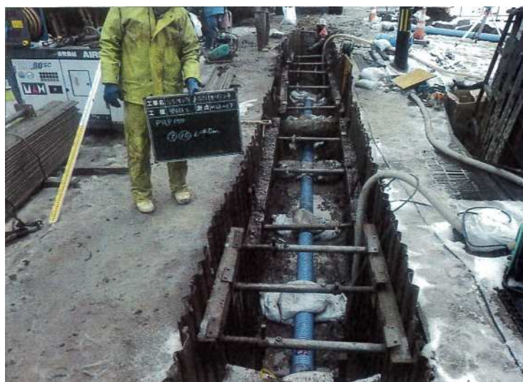
未普及工事【あわら市】
