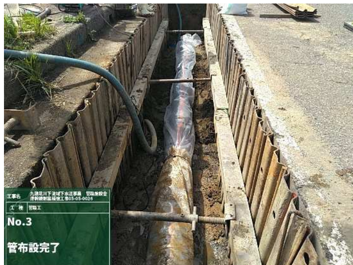
金津幹線耐震工事【九頭竜川流域下水道】
