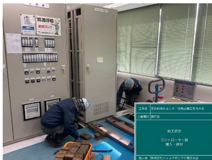
美浜町浄化センター老朽化対策工事（中央監視）【美浜町】
