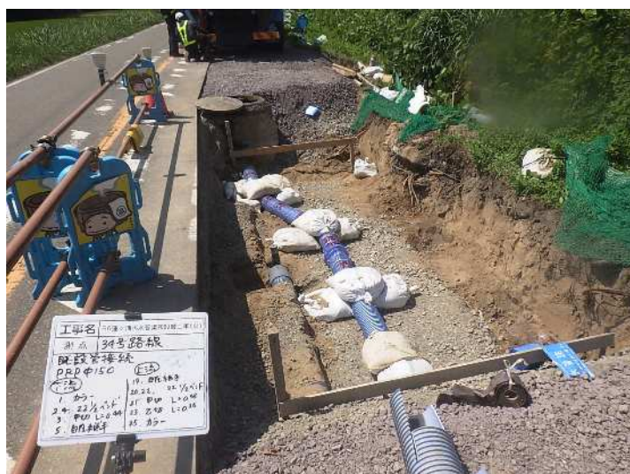
蓮ヶ浦汚水管渠布設替工事（災害復旧）【あわら市】
