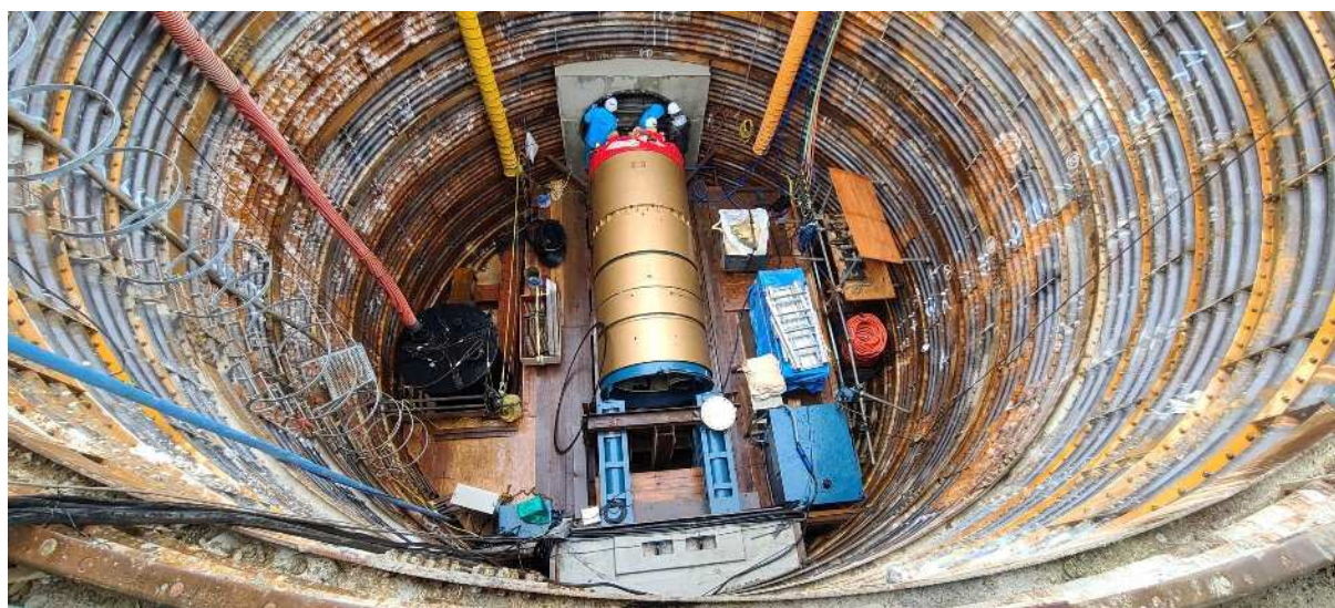
三谷川流域浸水対策 大蓮寺バイパス幹線整備工事【勝山市】
