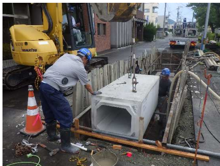
雨水渠（開削）整備工事【小浜市】
