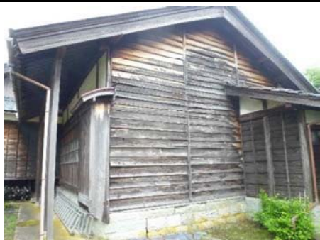
写真番号 5 調査場所 建物外観 状況メモ 西面
