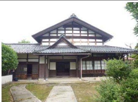
写真番号 1 調査場所 建物外観 状況メモ 東面
