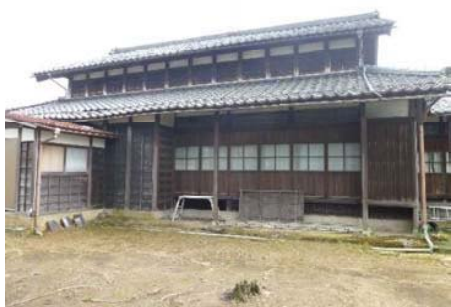
写真番号 3 調査場所 建物外観 状況メモ 北面
