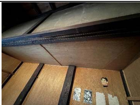
写真番号 24 部屋名 1階和室6帖(1)収納天井
