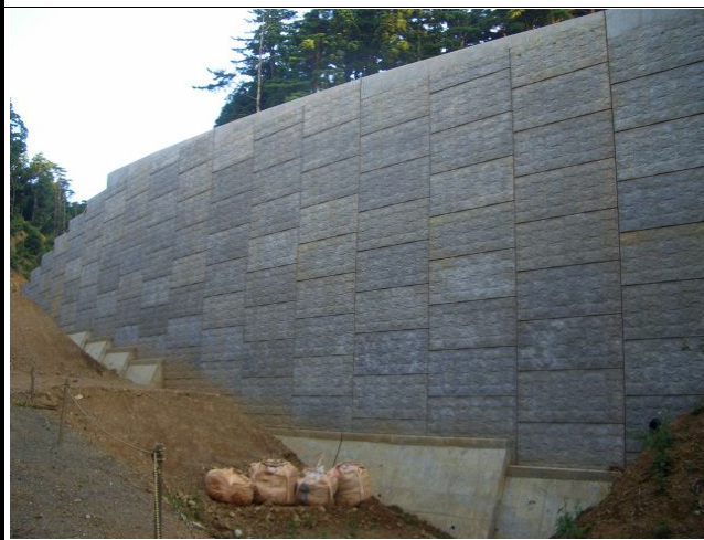
活用事例写真(活用部全景)
