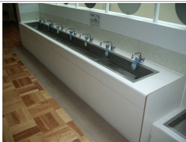
活用事例写真(活用部全景)
