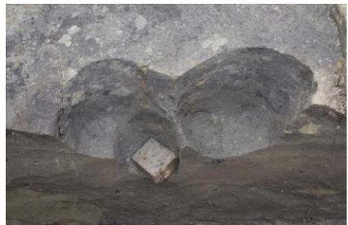
写真 2 礎板の残る柱穴
