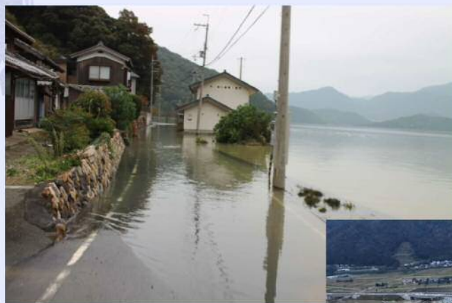
平成29年台風21号浸水状況
