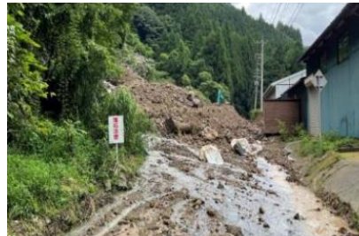
7月大雨被害の様子
