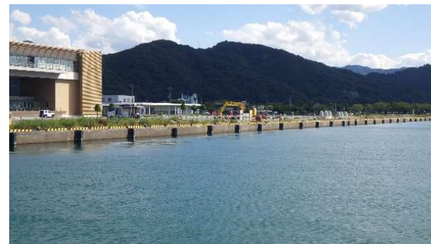
小浜漁港岸壁
