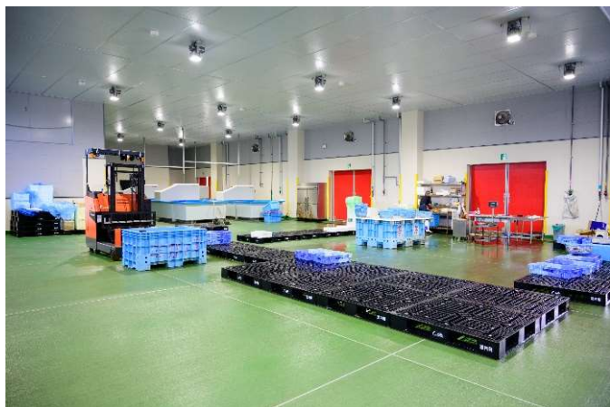
衛生管理型荷さばき施設
