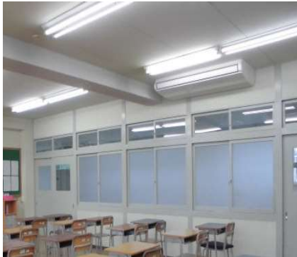
【普通教室の空調設備整備】
